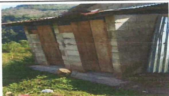
Foto 5: Mejoramiento de servicios sanitarios
