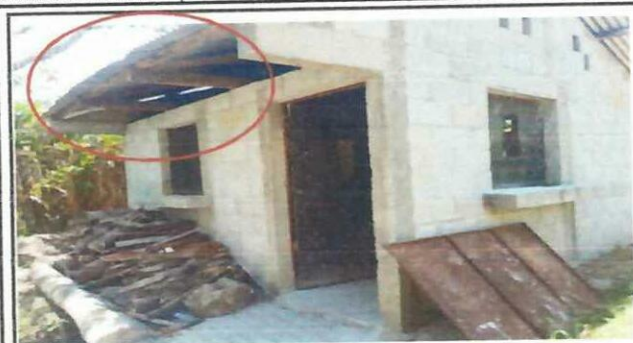
Foto 1: Sustrucción de lamina por lamina troquelada y sustrucción de estructura de soporte de madera por costanera
