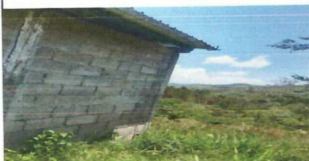
Foto 4: Sustrucción de canales , reparación de bajada de agua y cernido de pared
