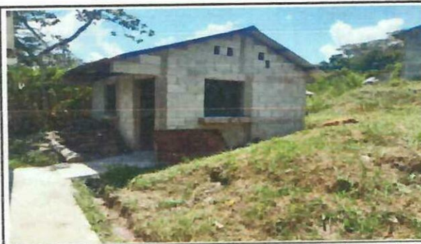
Foto 6: Mejoramiento y Reparacion de cocina, cernido de pared de block
